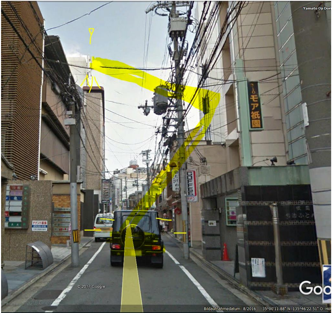
Sender auf Gebäude vor Kreuzung . In den aktuell aufgeschalteten weiteren Aufnahmen von google-street view vom 2.18 ist dieses Gebäude in einem Gerüst eingepackt zu sehen:
