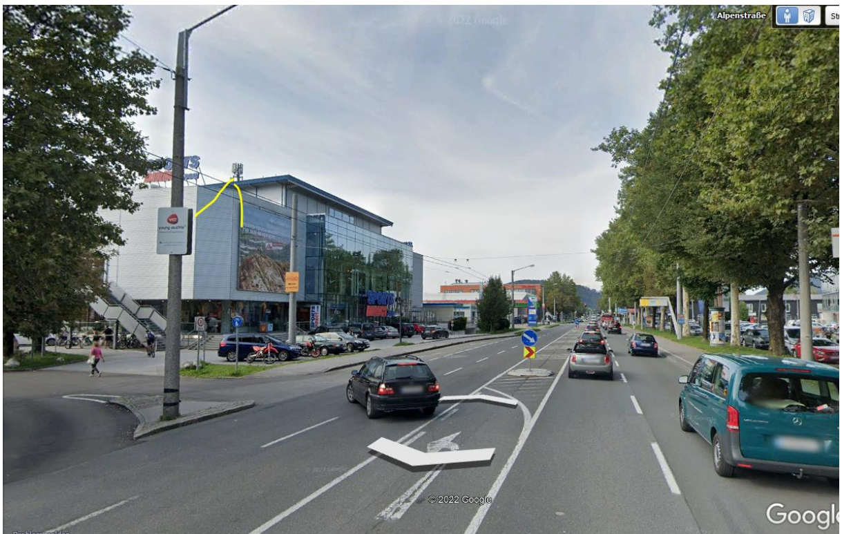
Die Reflexion an der schräggestellten Fassade führt hier zu einer Verdoppelung der auftreffenden Strahlungsintensität
