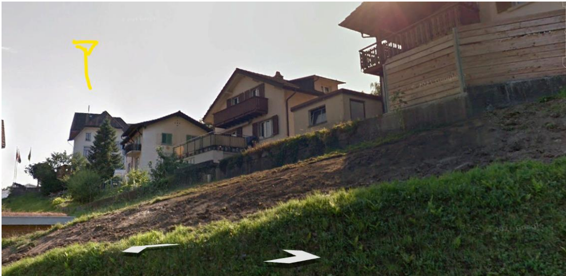
Aufnahme 2013. Ein Neubau später links, Verbindung ist aber sichtbar.
