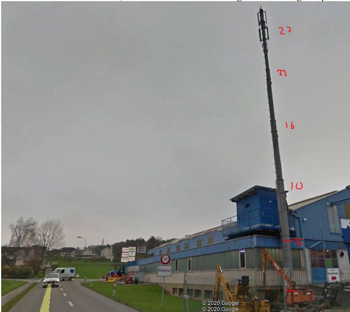
Sender im NO ist hoch montiert, wird aber durch dazwischenliegende Gebäude gedämpft
