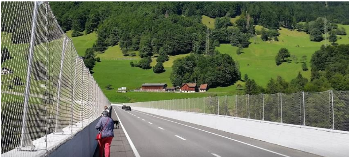
hier rechts neben dem Brückenkopf der Hang mit der Absturzstelle.
