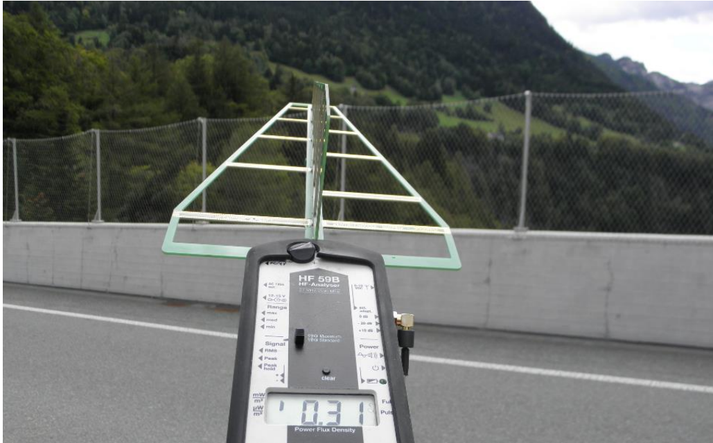
Im unteren Kurvenabschnitt ist kein abschirmendes Gitter mehr
